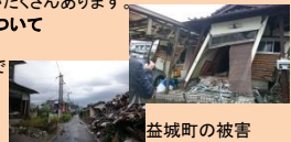
益城町の被害
